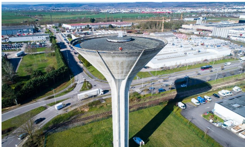
Figure 11: Réservoir de Longvic
