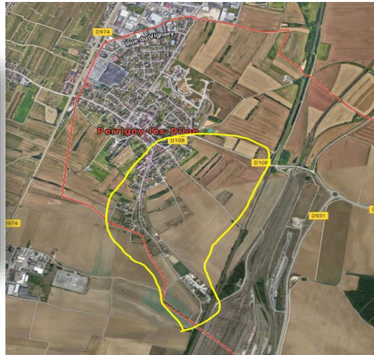
Figure 31: Zone impactée par la rupture
