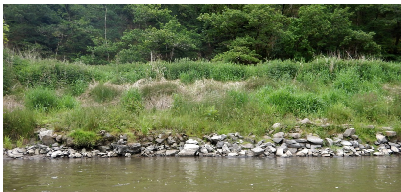
Figure 3.18 : Ligne de bloc en pied de berge sur la Sélune (R. Létondot, 2019)
