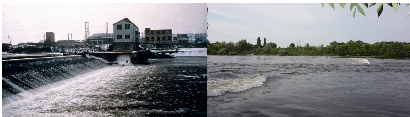
Figure 1.15 : Le barrage de Maisons-Rouges avant/après son dérasement (Dam Removal, 2019)
