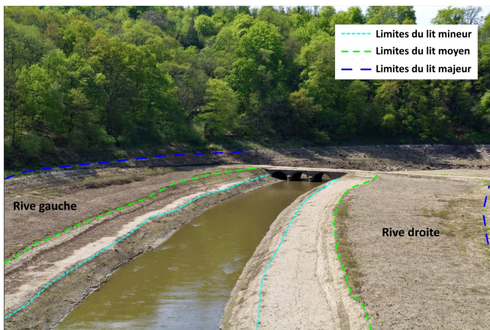
Figure 3.36 : Recalibrage du lit de la Sélune au niveau du Pont des Biards (R. Létondot, 2019)
