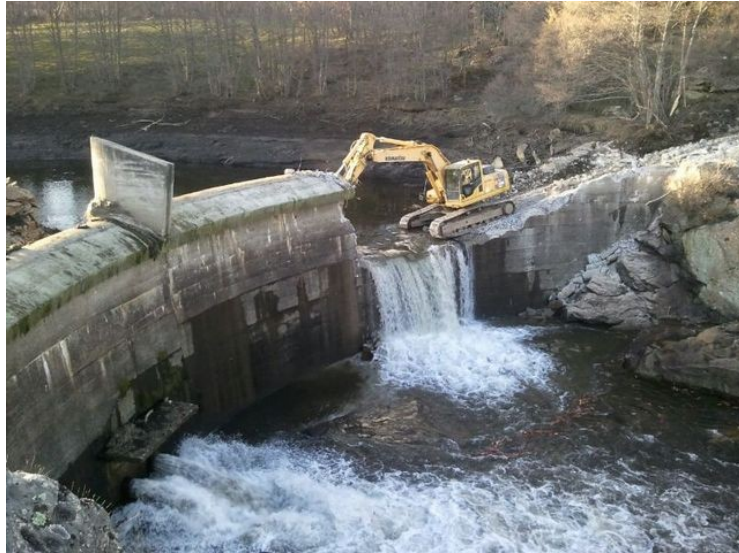
Figure 1.17 : Le début du démantèlement du barrage de Retuerta en Espagne (Dam Removal, 2019)
