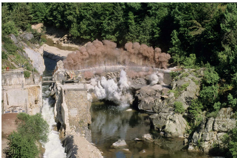
Figure 1.14 : Le dynamitage du barrage de Saint-Etienne du Vigan en juin 1998 (Dam Removal, 2019)
