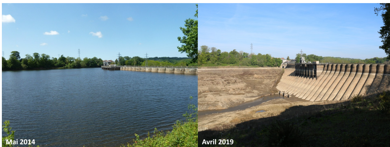
Figure 2.17 : La retenue du barrage de Vezins avant/après la vidange d'avril 2019 (R. Létondot, 2019 ; Syndicat mixte du bassin versant de la Sélune, 2014)
