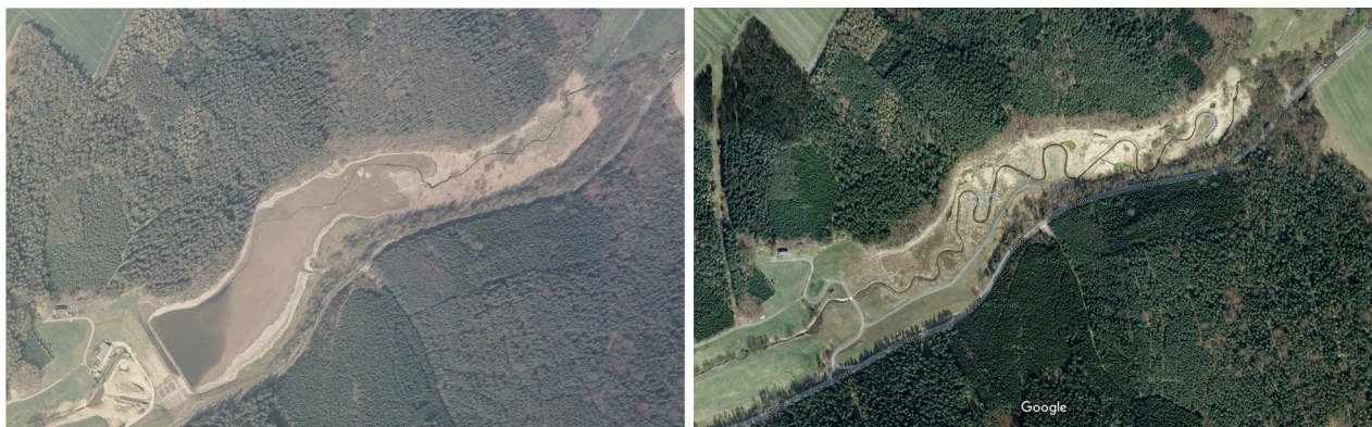
Figure 1.16 : La rechannelisation du cours d'eau en amont du barrage de Kresbach (Dam Removal, 2019)
