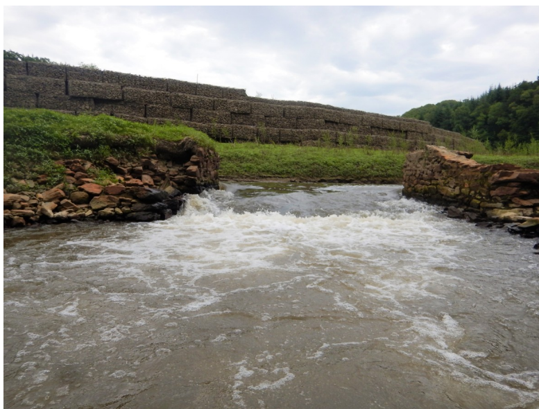
Figure 4.41 : Chute d'eau au niveau de l'ancien Grand Moulin des Biards (R. Létondot, 2019)
