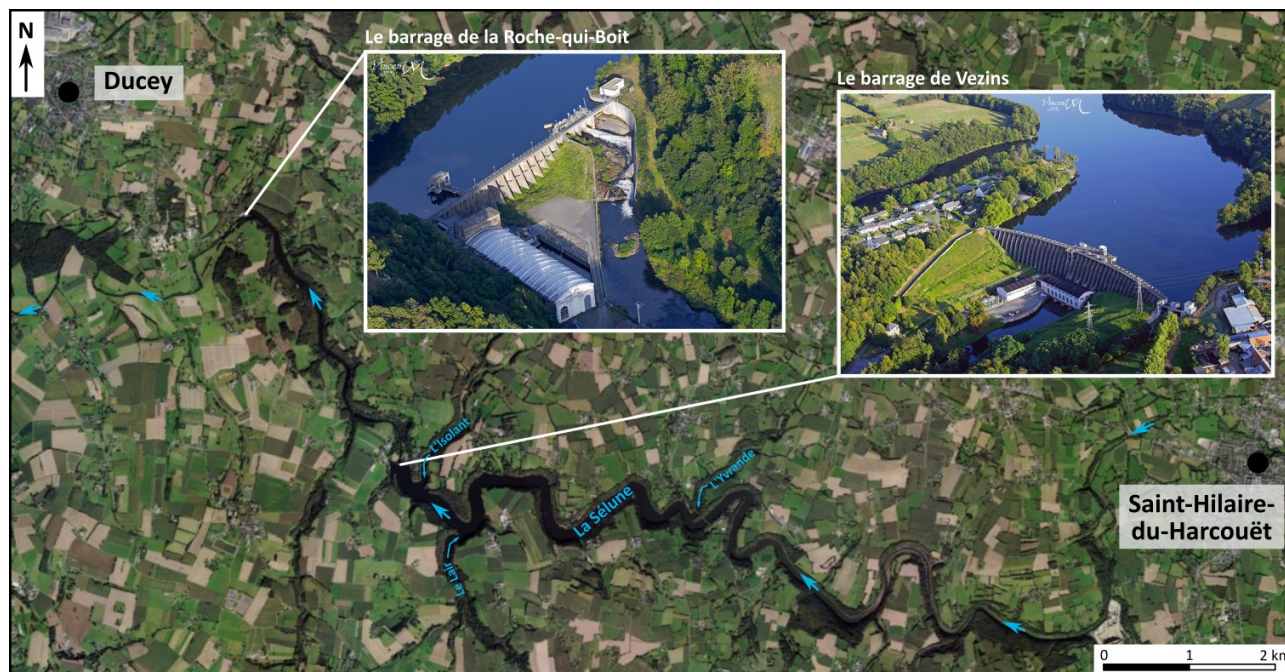
Figure 2.8 : Les barrages de Vezins et de la Roche-qui-Boit sur la Sélune (R. Létondot, 2019, d'après Germaine, 2013 et Vincent M, 2016)
