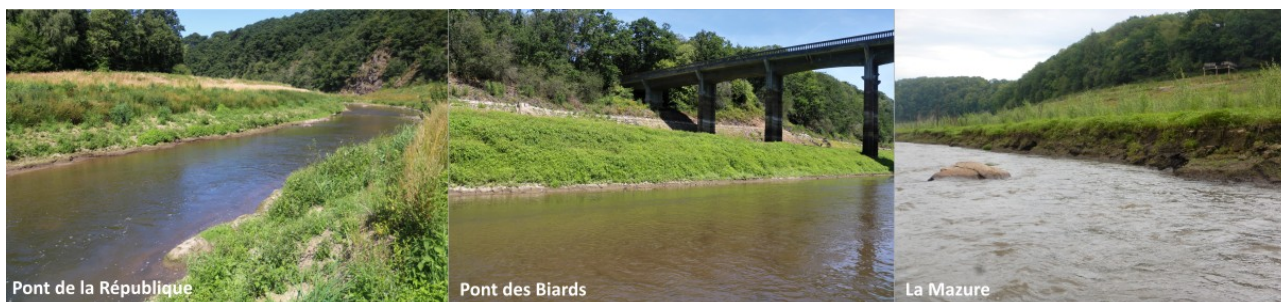
Figure 4.11 : Photographie des berges sur les trois sites d'étude de la Sélune (R. Létondot, 2019)
