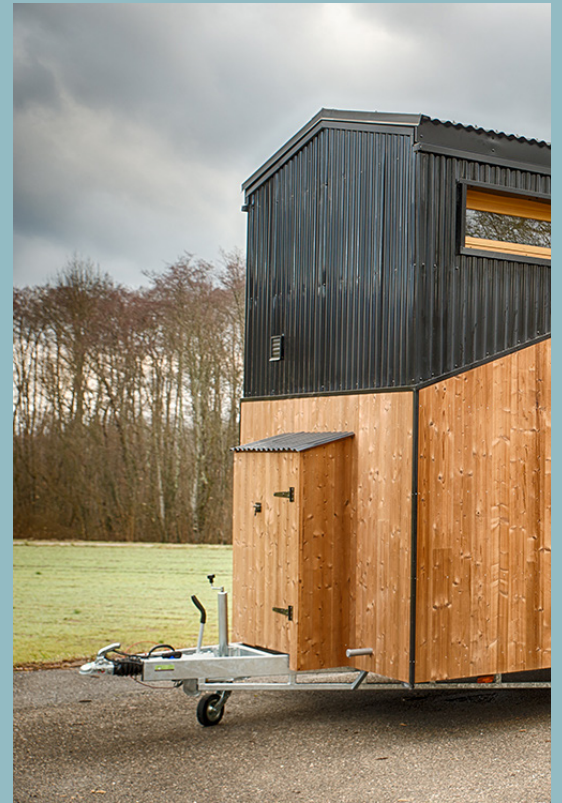
Photo 35 : Coffre technique extérieur
