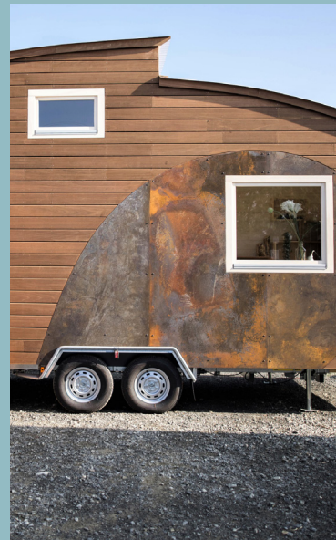
Photos 21 : Le bardage avec divers matériaux
