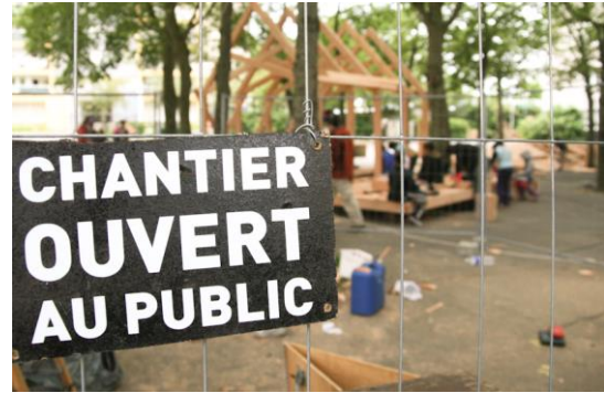
Figure 22 : Chantier ouvert Place de Prague à Rennes (35) – Source : collectif ETC
