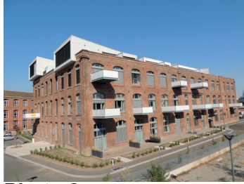
Photo 2. Ancien bâtiment de la SACM - Mulhouse
