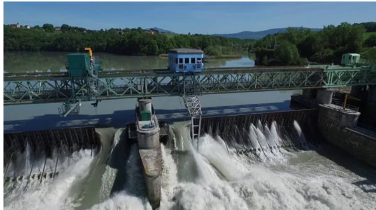
Figure 8: Opérations de gestion sédimentaire sur le Haut-Rhône à Seyssel. Compagnie Nationale du Rhône, 2016.
