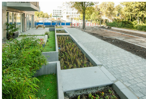
Figure 31 : Les bandes d'infiltration vertes à Zuidelijke Wandelweg, à Amsterdam © Agence Breevast
