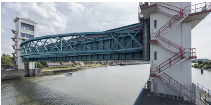
Figure 11 : Le barrage anti-tempête de Stormvloedkering Hollandsche IJse sur l'Yssel Hollandais © Rijkswaterstaat
