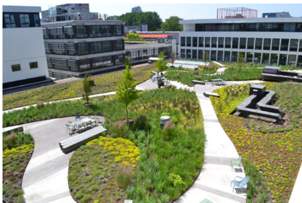
Figure 30 : Un toit végétalisé à Vivaldistraat, dans le quartier d'affaires Zuid d'Amsterdam © Agence Breevast
