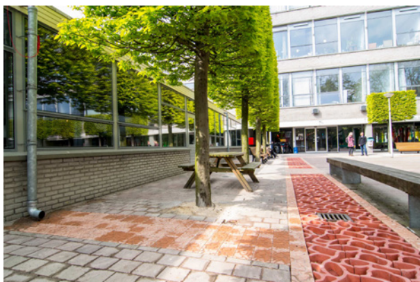
Figure 32 : Des matériaux facilitant le drainage de l'eau © Adam Nowek
