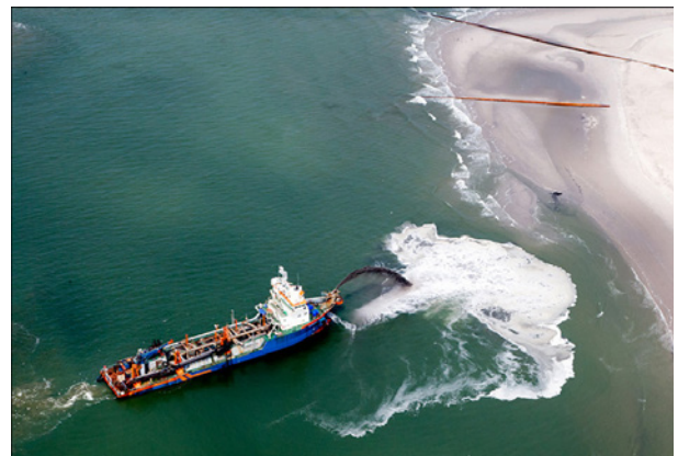
Figure 15 : Le rechargement en sable © Ifremer/Laure Simplet
