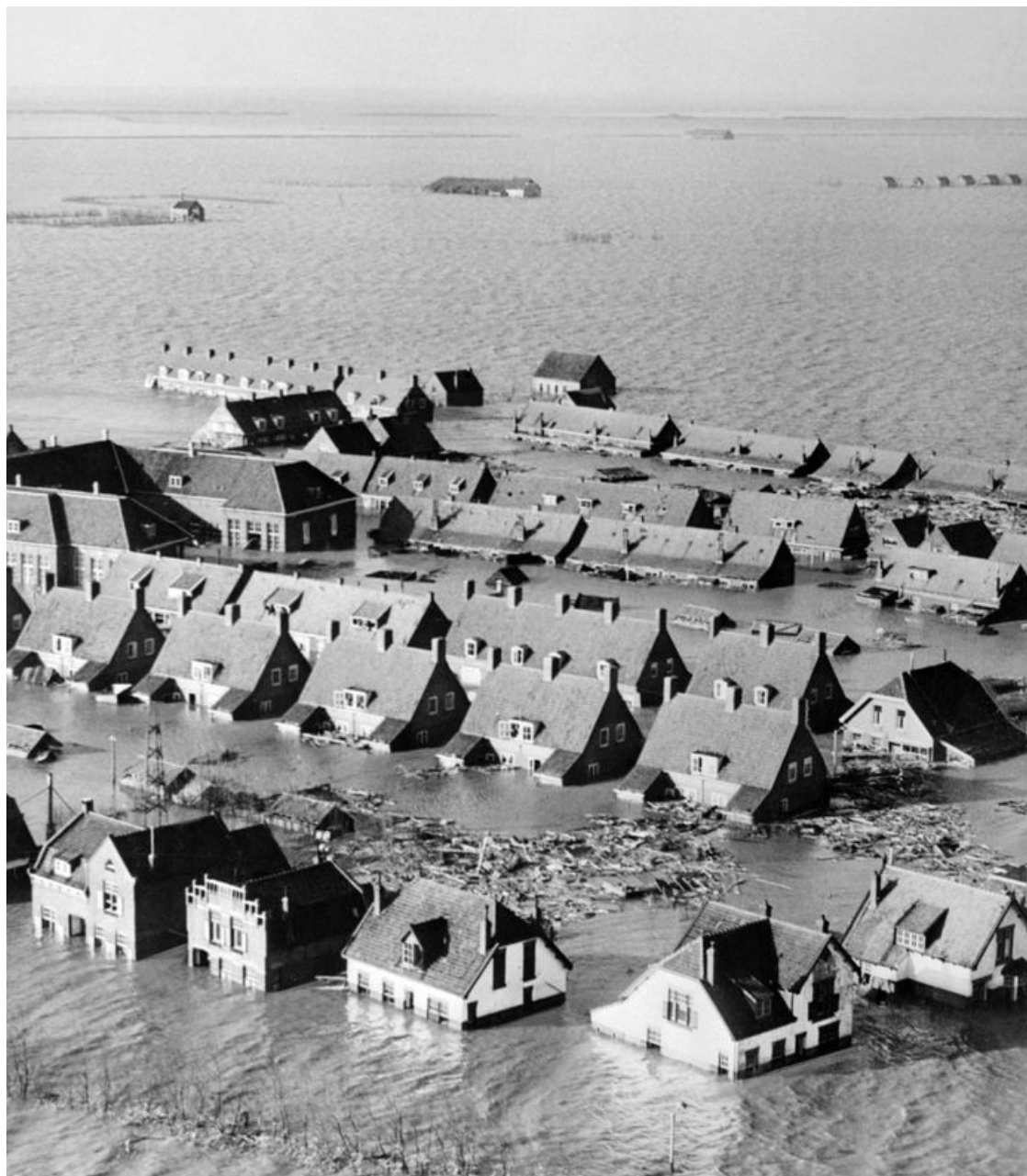
Figure 10 : Le village d'Oude Tonge dans la province de la Zélande, dévasté après le raz de marée de 1953 © La Croix
