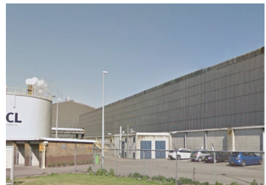
Figure 42 : Station assurant l'approvisionnement en carburant de l'aéroport Schiphol © Rijkswaterstaat
