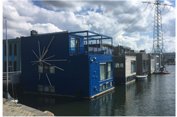
Figure 36 : Maisons flottantes, IJburg, Amsterdam © Gaëlle Duffieux
