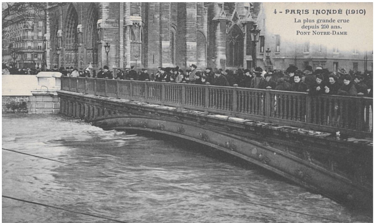
Figure 18 : La crue de 1910 à Paris, pont Notre-Dame © Archives de la ville de Paris
