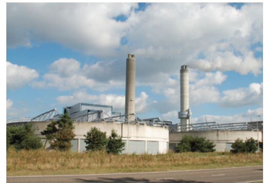
Figure 41 : Usine de traitement des eaux usées © Rijkswaterstaat
