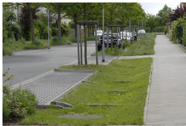
Figure 33 : Les baissières, dispositif d'absorption de l'eau © Agence CG Concept
