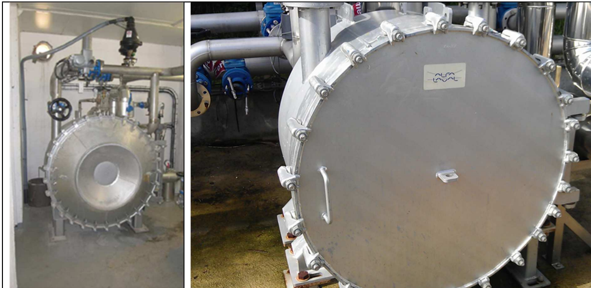
Photographies 05 et 06 – Echangeur déporté spiralé (Source : VEOLIA)
