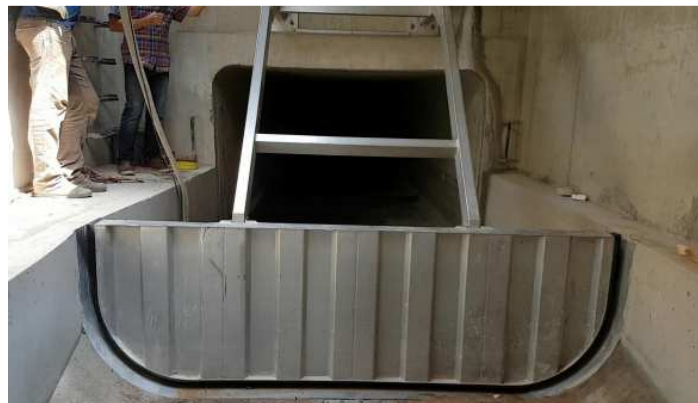
Photographie 12 - Dispositif de chasse amont (Source : Dr. Jan Butz, Klinger et Partner)
