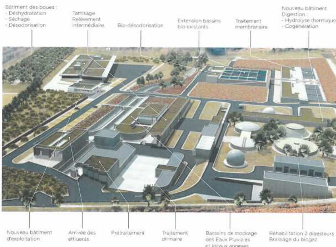
Figure 28 – Fonctionnement de la station de « carré de réunion »
