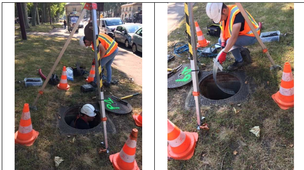
Photographies 07 et 08 - Mise en œuvre du capteur de vitesse
