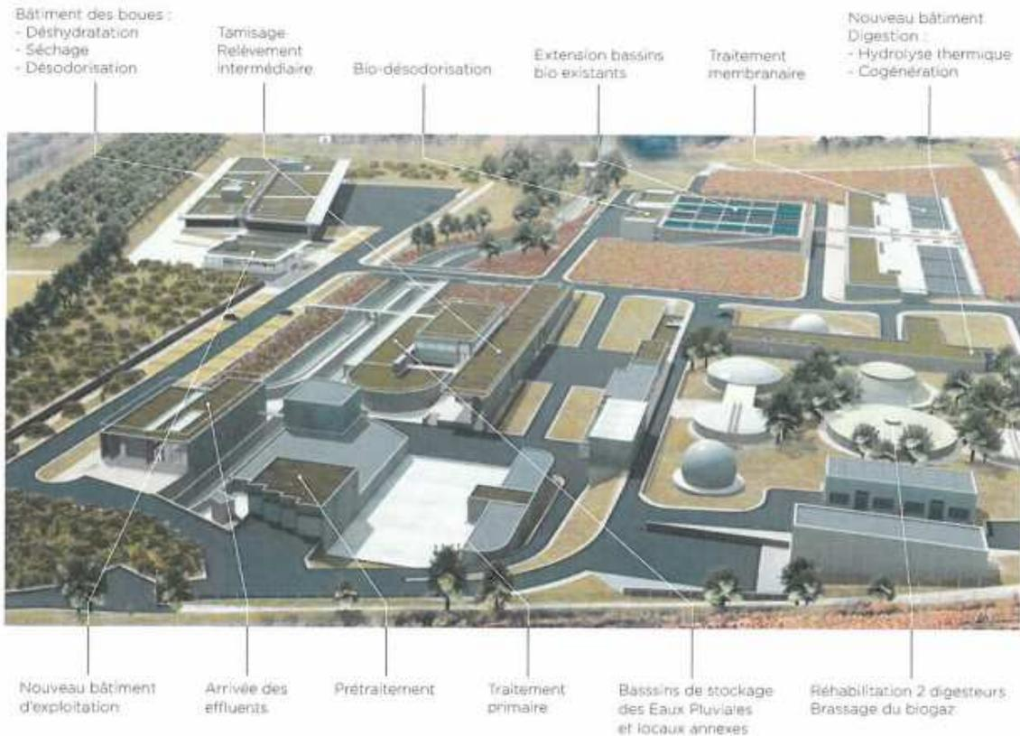
**Figure 28 – Fonctionnement de la station de « carré de réunion »**
