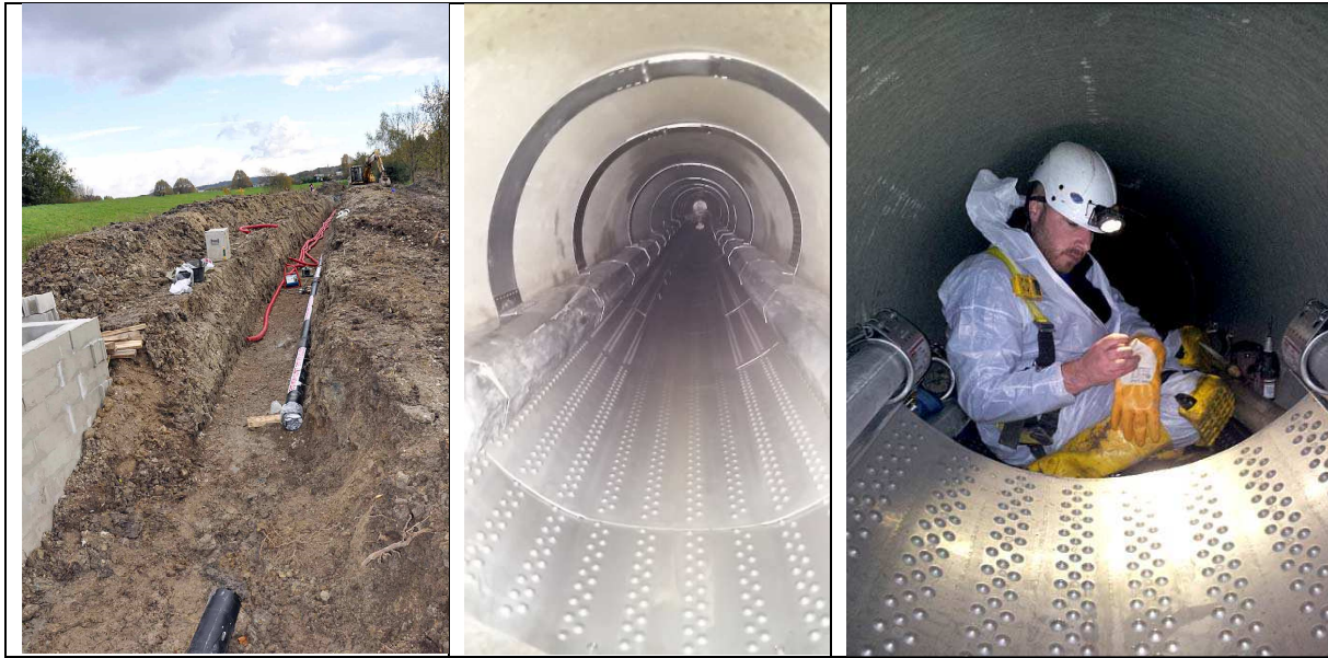
Photographies 15, 16 et 17 – Mise en œuvre échangeur à plaques SIAHVY
