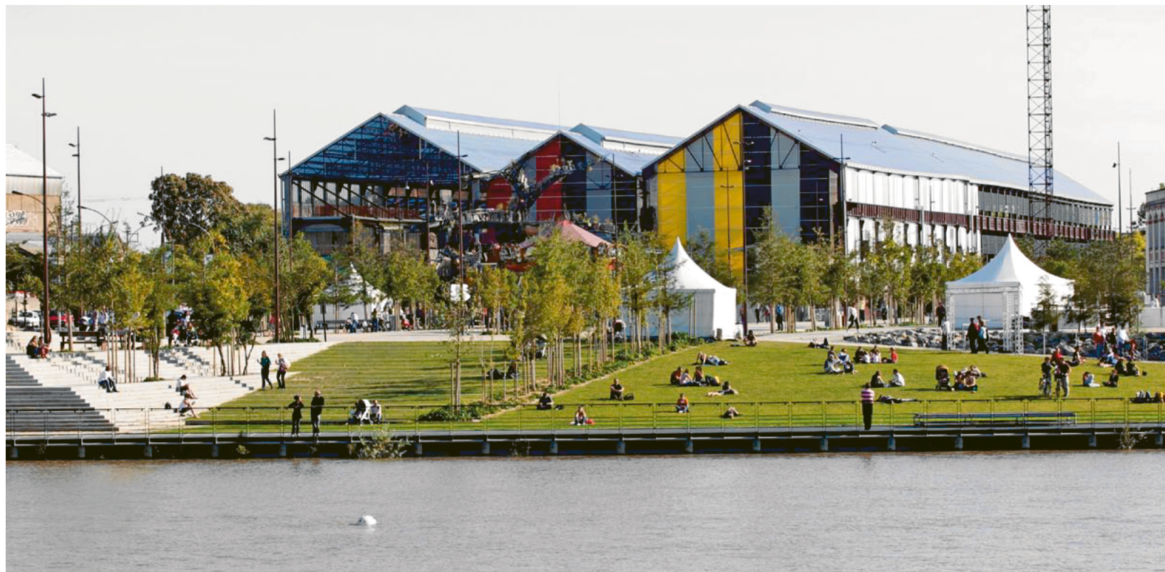
FIG.10 Photo des Nefs après les travaux, en septembre 2008. Projet Parapluie Urbain, Alexandre Chemetoff & Associés. Crédit photo Arnauld Duboys Fresney.
