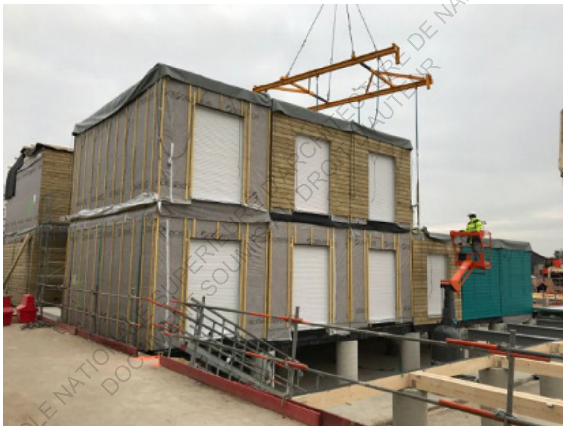
VISUEL 32- Construction du centre d'hébergement d'urgence sur les bassins filtrants de l'ancienne usine des Eaux de Paris à Ivry-sur-Seine (Val-de-Marne)
