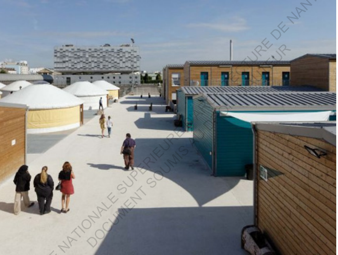
VISUEL 33 - Centre d'hébergement d'urgence Atelier Rita (architectes), Emmaüs Solidarité (maître d'ouvrage) 2017
