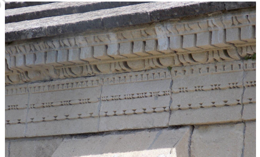
Réemploi de patrimoines antiques au Moyen-Âge. Détails de la corniche ornant la façade méridionale de la cathédrale Notre-Dame-de-Nazareth à Vaison, dans le Vaucluse. Les blocs utilisés pour l'ornementation proviennent du forum romain voisin. Source : photographies C. Lefebvre.
