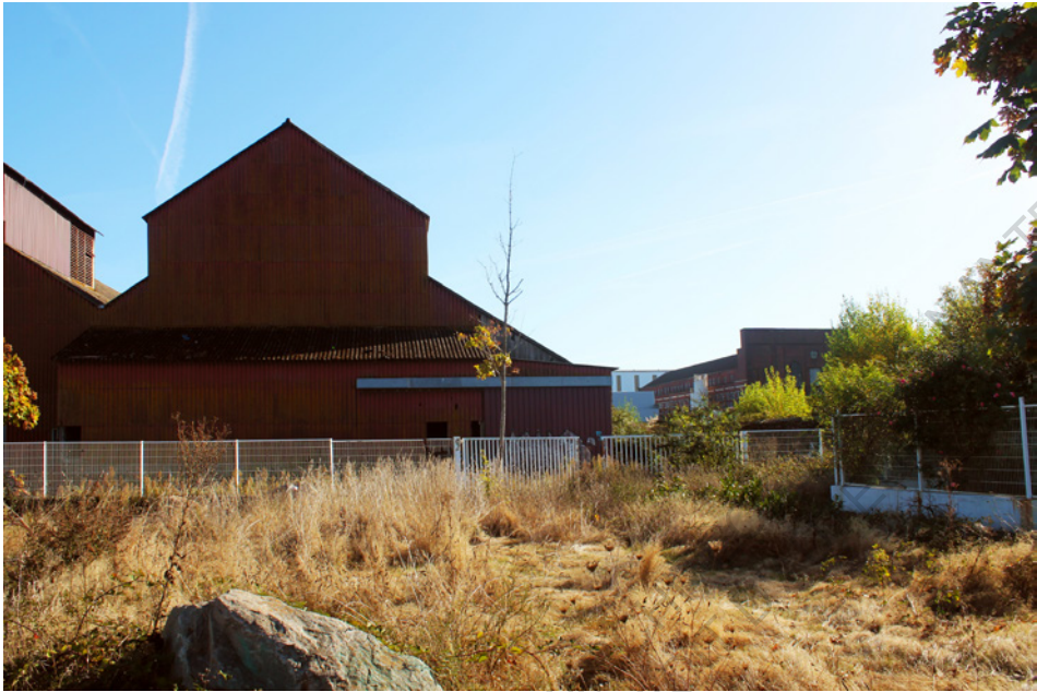
Friche industrielle, rue des Usines, Bas Chantenay
