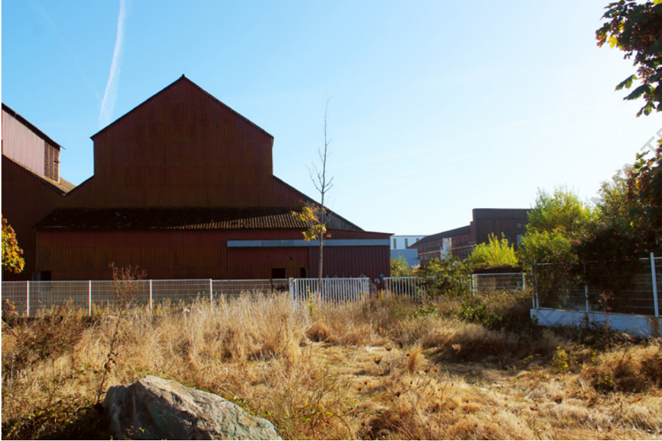
Friche industrielle, rue des Usines, Bas Chantenay
