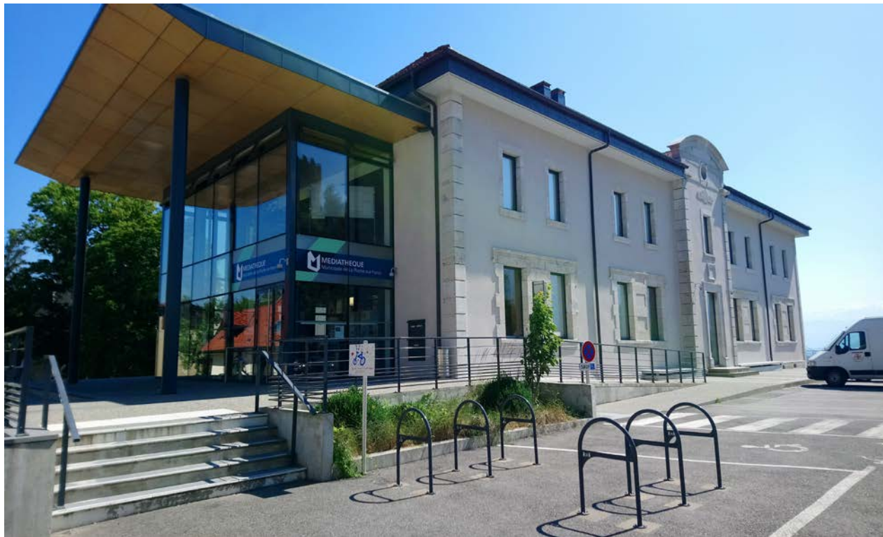
Médiathèque municipale de La Roche-sur-Foron (source : image personnelle).
