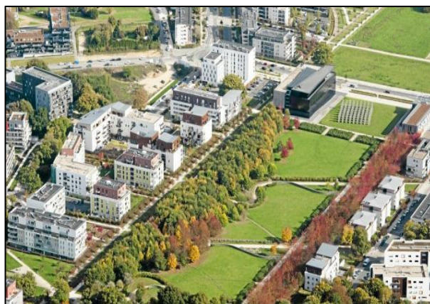
Figure 6 : Photo oblique du parc de Beauregard (David Adémas ©)
