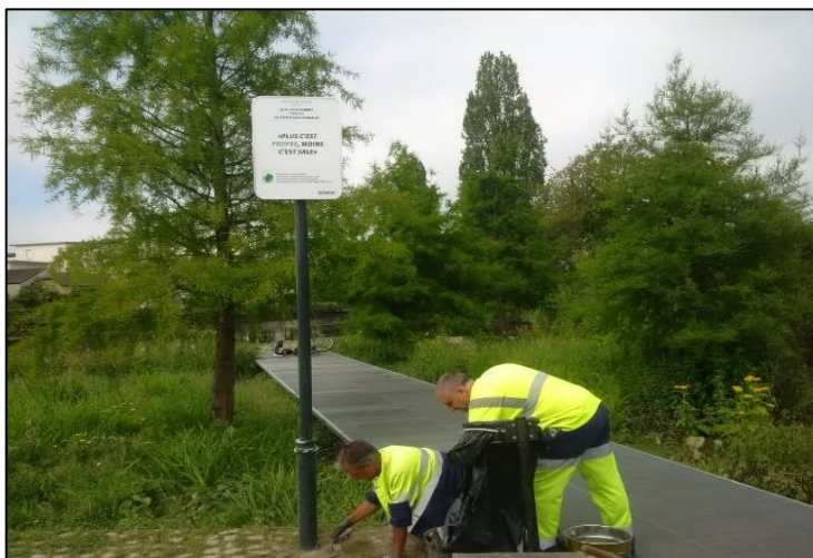
Figure 31 : Installation des panneaux d'informations. (Cyrille Morel ©)
