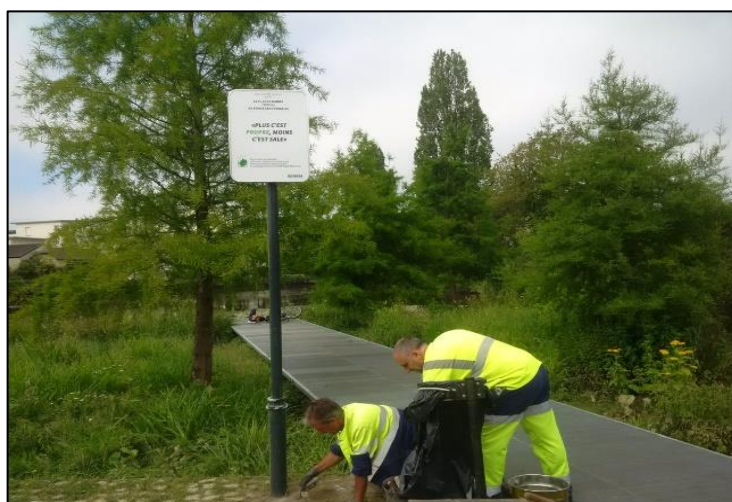
Figure 31 : Installation des panneaux d'informations. (Cyrille Morel ©)
