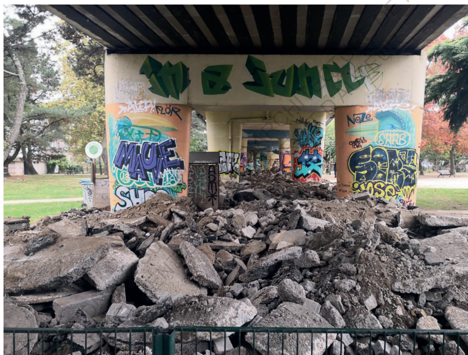
Mise en place de gravats au square Vertais à Nantes © Stéphane Pajot
