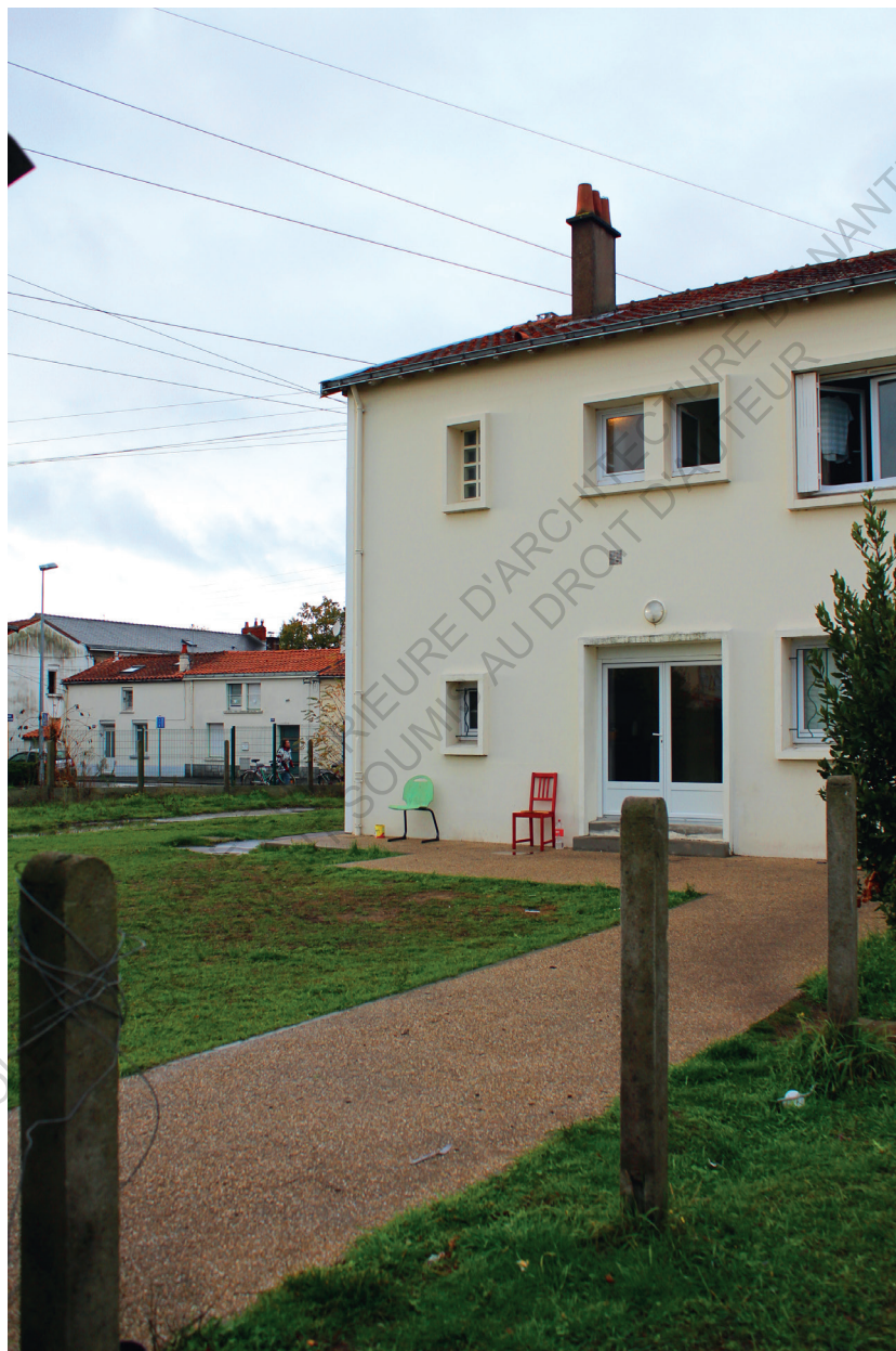
Vue extérieure d'une des maisons du squat de la Gilarderie
