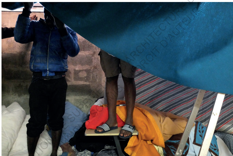
Chantier de l'isolation du hangar occupé par les mineurs au squat Wilson © collectif de soutien migrants 44
