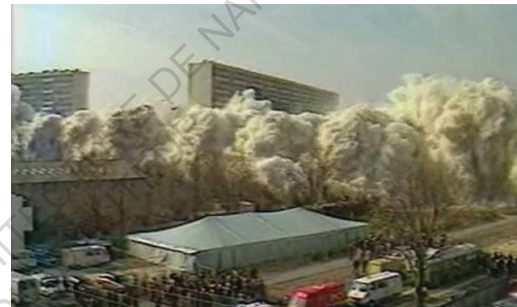
Figure 1 - Implosion de la barre Debussy à la cité des 4000 à la Courneuve en 1986
