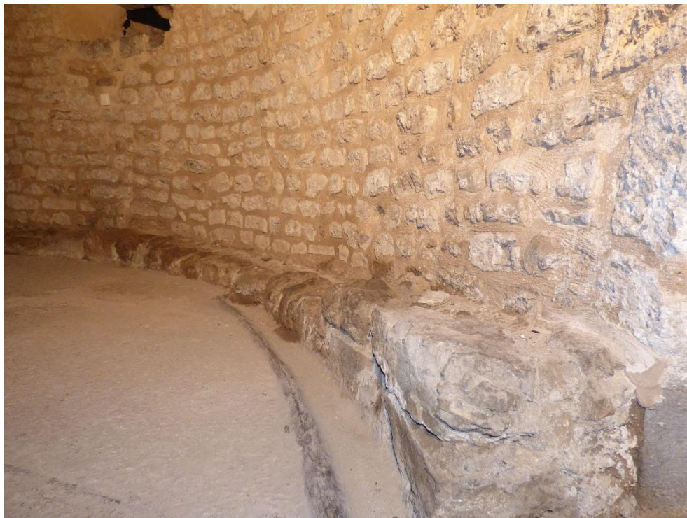
Fig. 42 – Église Saint-Pierre de Lémenc, Chambéry (Savoie), « banquette », mur occidental de la rotonde
