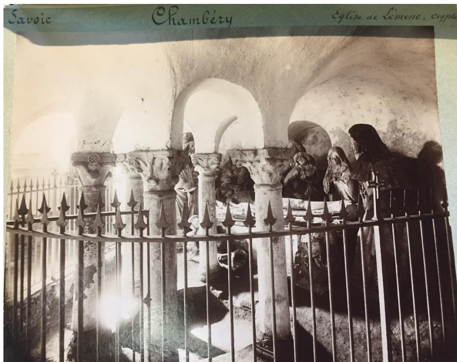
Fig. 56 – Église Saint-Pierre de Lémenc, Chambéry (Savoie), rotonde, l'oculus n'est pas ouvert
