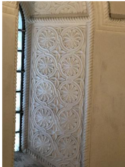
Fig. 69 – Église de la Très-Sainte-Trinité, Germigny-des-Prés (Loiret), fenêtre de l'abside
