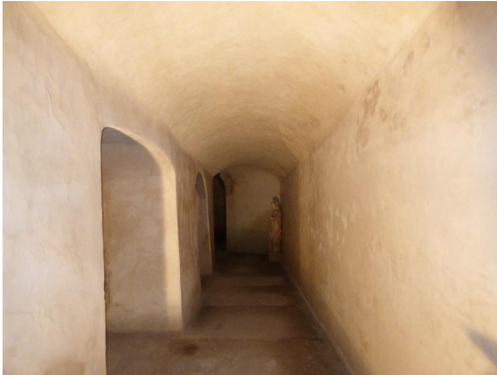
Fig. 20 – Église Saint-Pierre de Lémenc, Chambéry (Savoie), collatéral nord recouvert d’enduit
