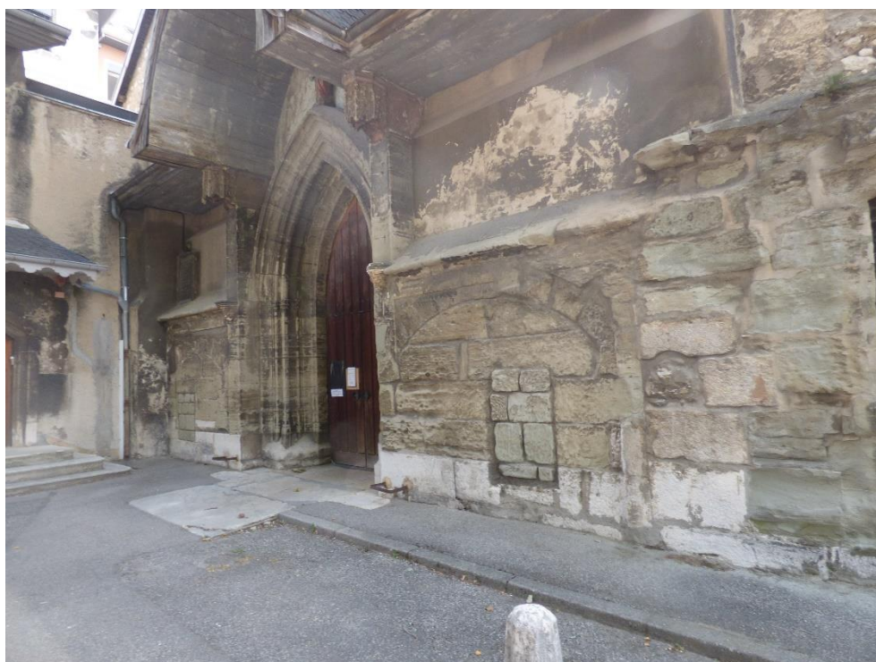
Fig. 25 – Église Saint-Pierre de Lémenc, Chambéry (Savoie), détail de la façade occidentale
