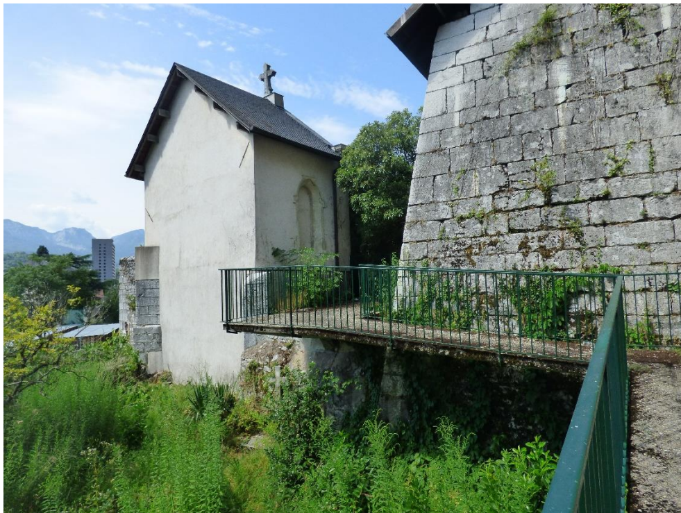
Fig. 27 – Église Saint-Pierre de Lémenc, Chambéry (Savoie), base de l'ancien clocher, façade sud
