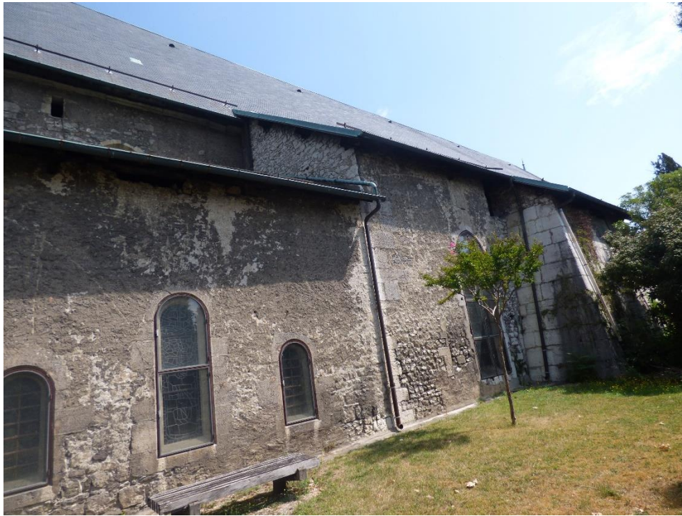
Fig. 26 – Église Saint-Pierre de Lémenc, Chambéry (Savoie), façade sud
