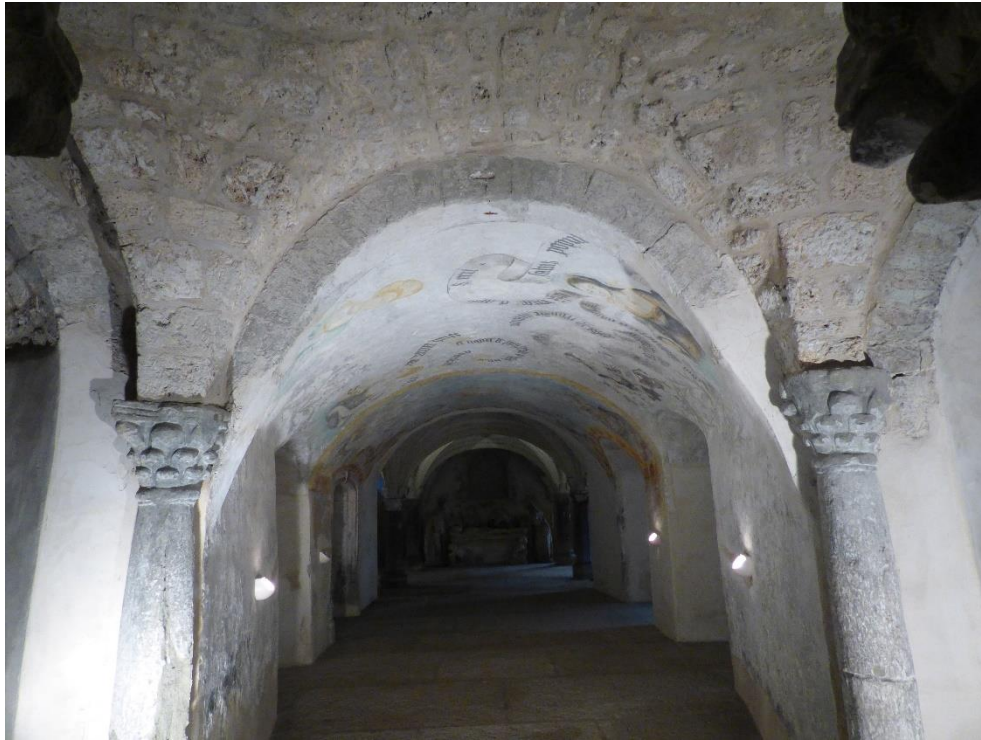
Fig. 37 – Église Saint-Pierre de Lémenc, Chambéry (Savoie), nef de la crypte
