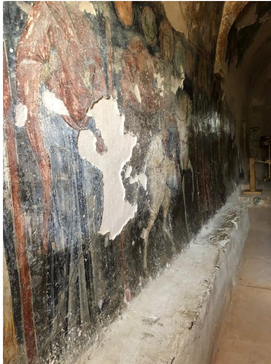
Fig. 43 – Église de la Panageria Keria, Krystia (Crète), mur gouttereau nord
