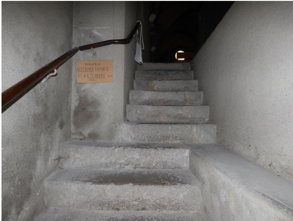
Fig. 55 – Église Saint-Pierre de Lémenc, Chambéry (Savoie), escalier sud
