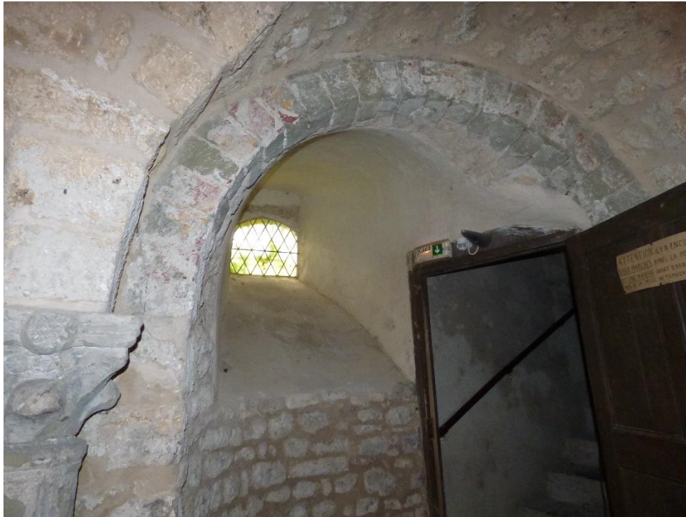
Fig. 61 – Église Saint-Pierre de Lémenc, Chambéry (Savoie), absidiole sud-ouest, fenêtre
