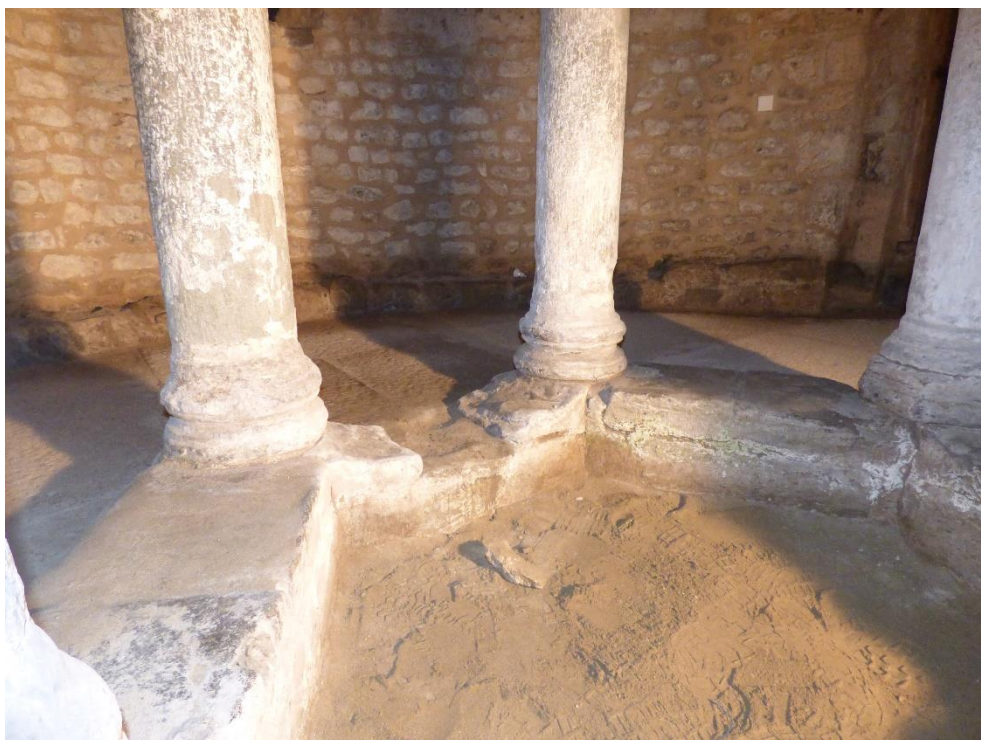
Fig. 44 – Église Saint-Pierre de Lémenc, Chambéry (Savoie), margelle hexagonale de la rotonde
