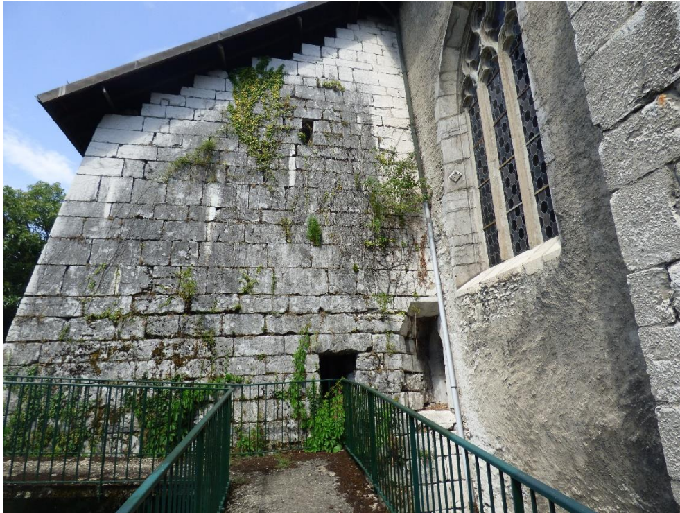
Fig. 53 – Église Saint-Pierre de Lémenc, Chambéry (Savoie), mur sud du chevet
