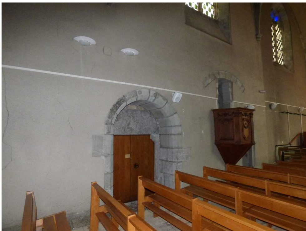
Fig. 17 – Église Saint-Pierre de Lémenc, Chambéry (Savoie), accès à la chaufferie et chaire
