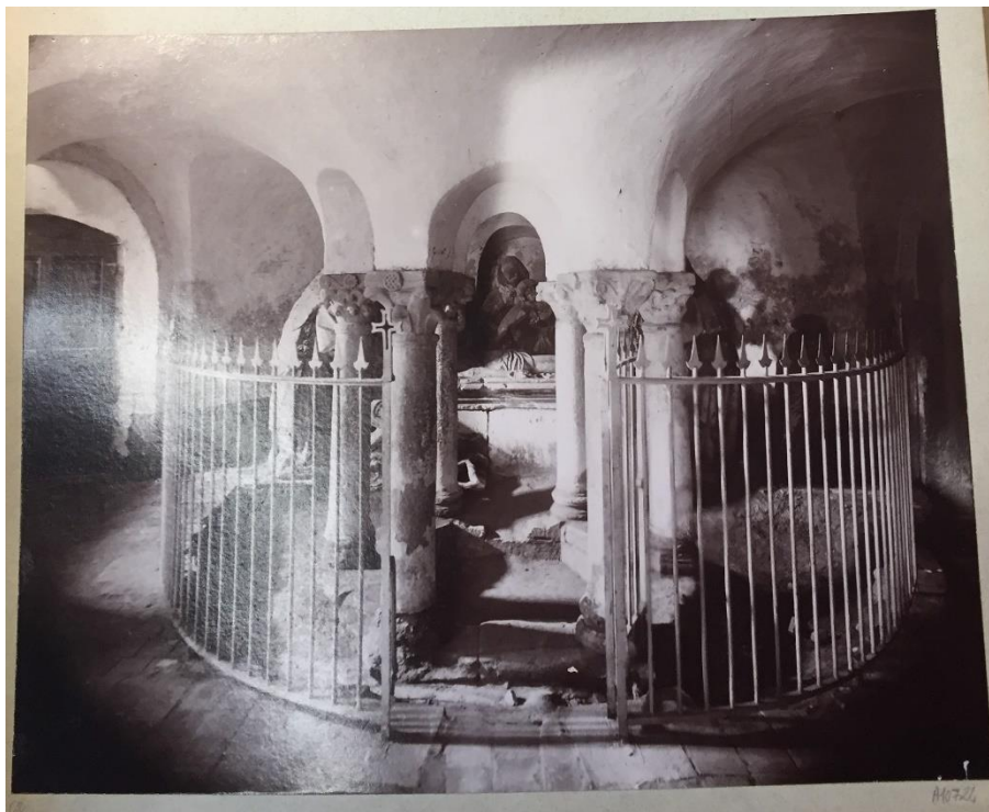
Fig. 19 – Photo de la rotonde, grille de protection
