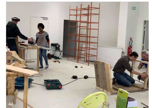
figure 44 : atelier bois pour la Galerie du Zéro Déchet
