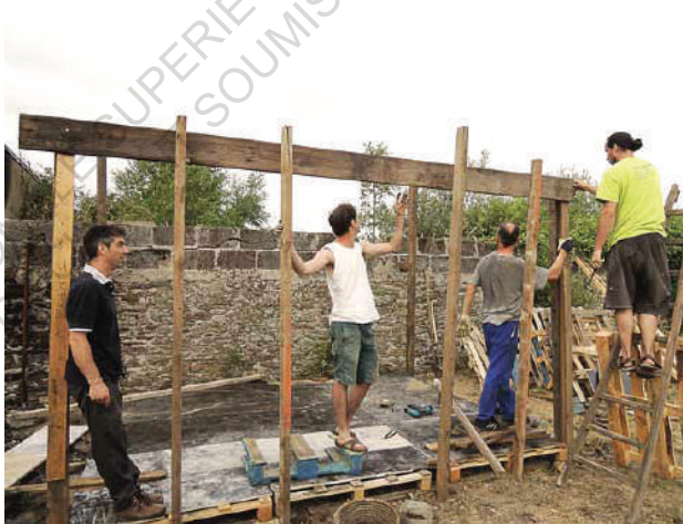
_Construction de la cabane à outils
