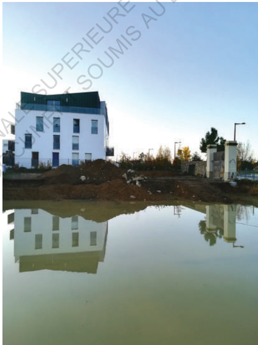
26 Novembre 2018_Mail Haround Tazief. photographie personnelle Il reste un morceau du mur mais derrière lui la ferme n'est plus.
