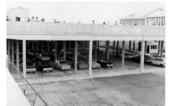
Sous la plateforme, la trame de poteaux organise un parking. © Association AJB
