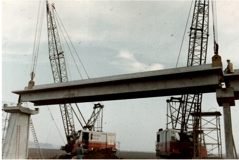
Deux engins de levage installent les poutres de 20 m. © Association AJB
