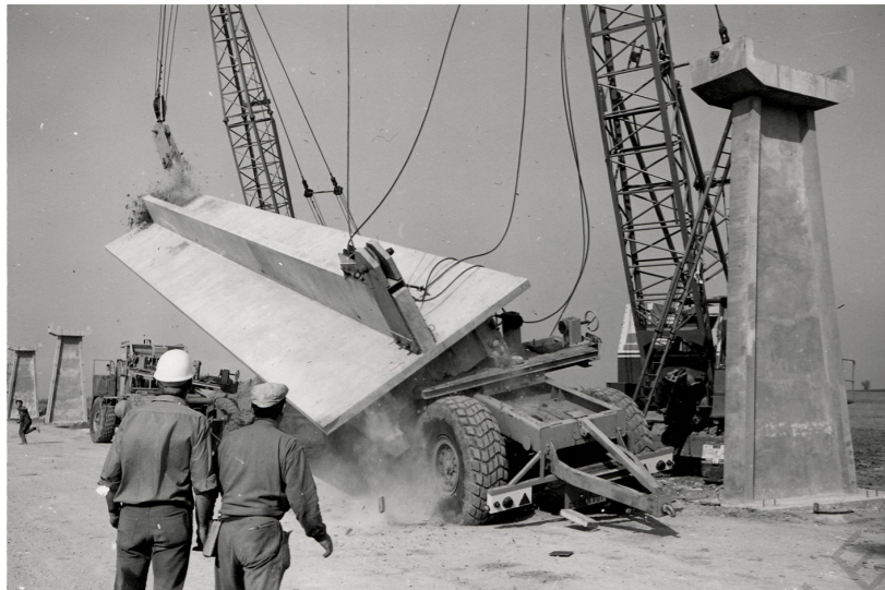
L'assemblage des poutres de 44 tonnes n'a pas été sans accroc. © Association AJB
