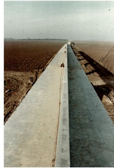
Sur la voie de 3,40 m de large, la bordure centrale de 90 cm de hauteur assure le guidage. © Association AJB
