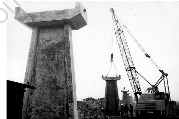
Des grues sur chenilles et divers engins de chantier circulaient le long du tracé. © Association AJB
