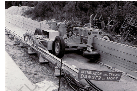
Essais du moteur électrique linéaire sur un chariot expérimental. © Association AJB
