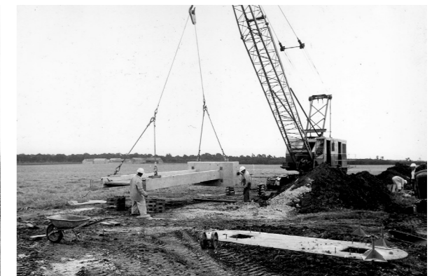
Chaque pile est assemblée à une semelle reposant sur des fondations sur puits. © Association AJB
