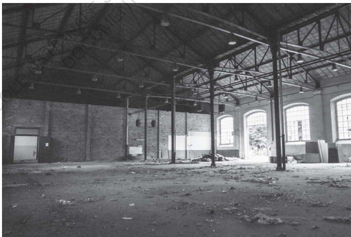
l'Ex caserne militaire, ÉTAT ACTUEL de la future Cité de la Science Out Door ©
