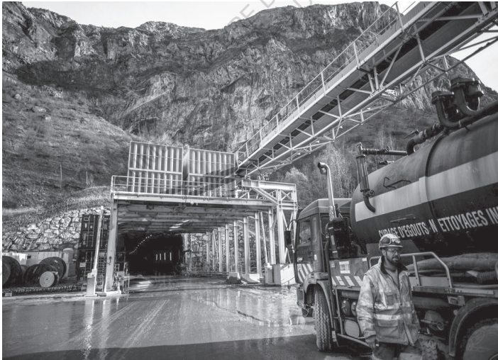
Le chantier de la TAV , Saint Martin La Porte, France, 29 novembre 2018
