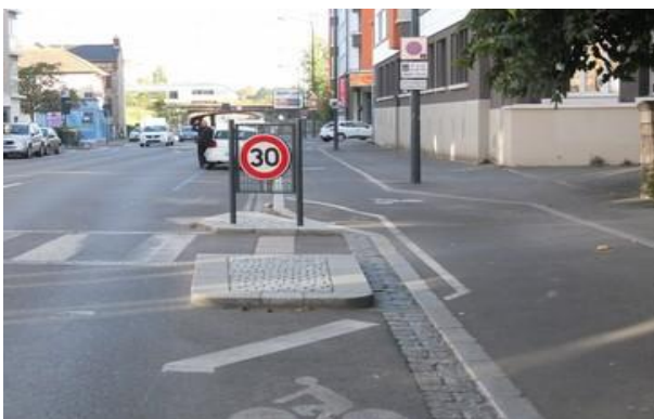
Figure 30: Bordure pavé sur entrée de piste cyclable Avenue MGR Mouezy
