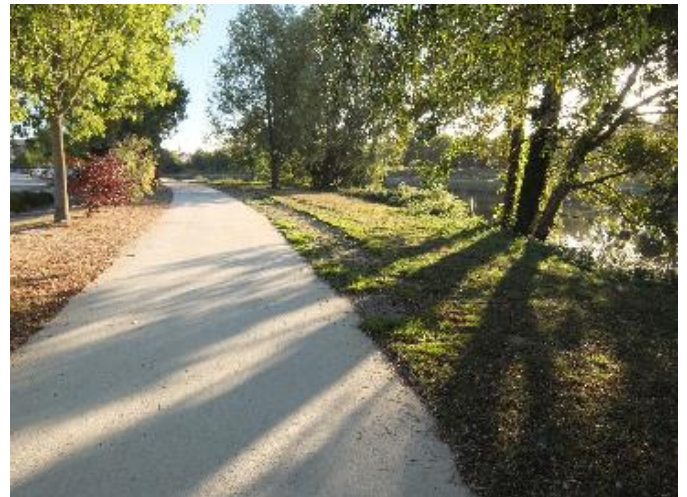
Figure 6: Chemin de halage au bord de la Vilaine
