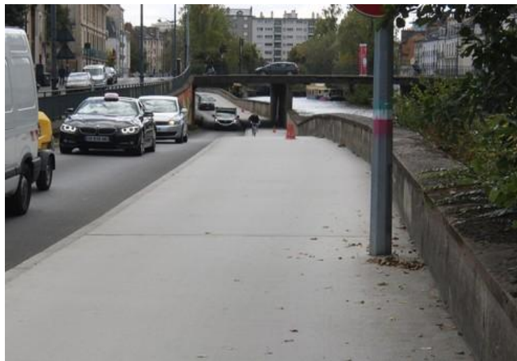
Figure 33: Revêtement de la nouvelle piste cyclable Boulevard Chézy
