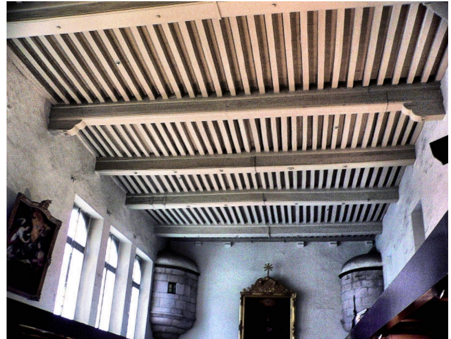
Plafond chaulé de l'Hôtel-Dieu de Beaune.
