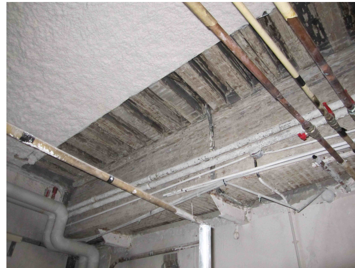
Bâtiment S (partie sud)
