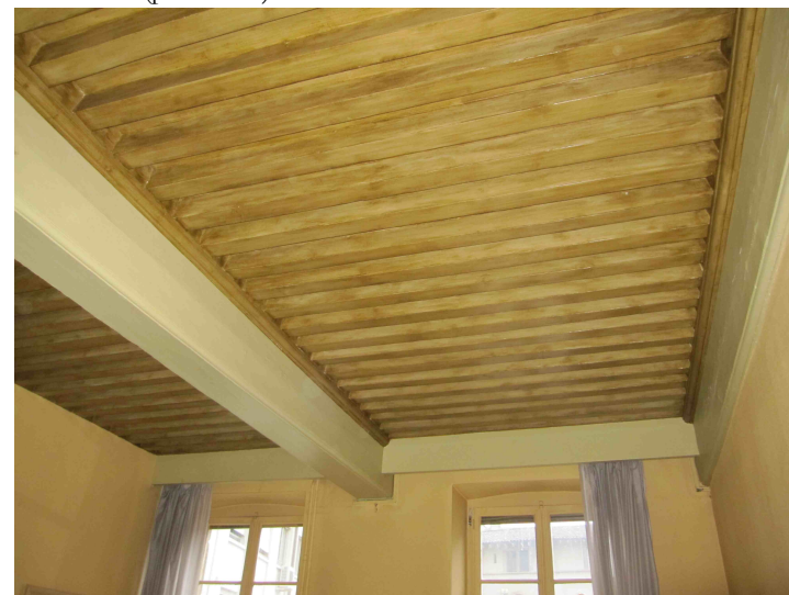
Bâtiment S (partie nord)
