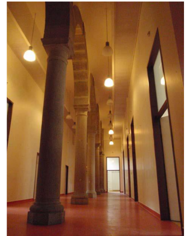
FIGURE 16 : PHOTO AVANT CURAGE/DEMOLITION - SOURCE : APPAREIL PHOTO PERSONNEL
