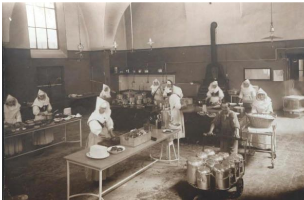
FIGURE 19 : CUISINES EN 1930 - SOURCE : CHANTIER GHD
