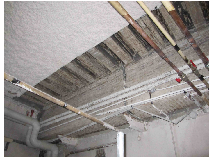
Bâtiment S (partie sud)
