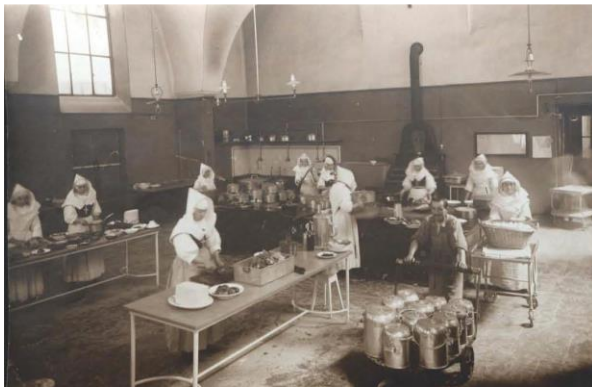
FIGURE 19 : CUISINES EN 1930 - SOURCE : CHANTIER GHD
