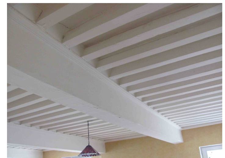
Plafond peint de la Maison de Pauline Jaricot à Lyon.
