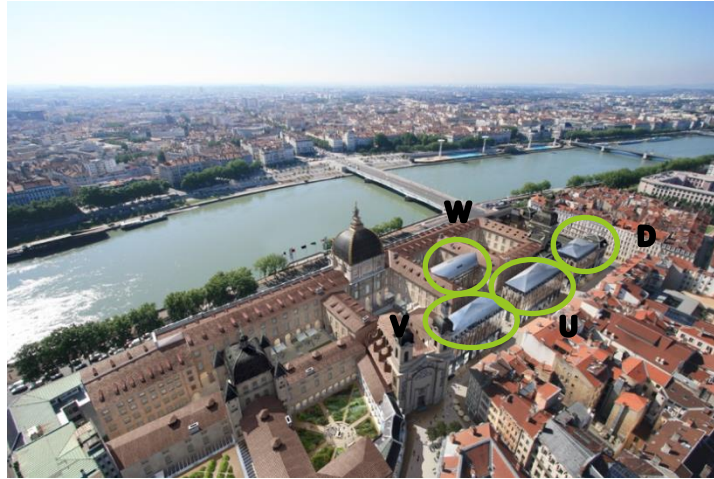
FIGURE 12 : VUE AERIEENNE SUR LES BATIMENTS NEUFS - SOURCE : CHANTIER GHD
