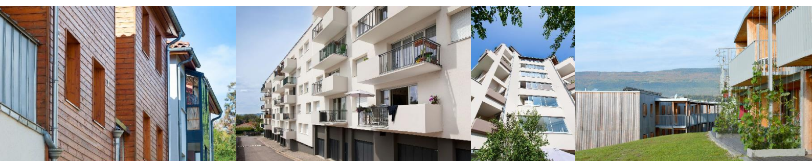
Figure 1 : de gauche à droite : Villars-les-Dombes, Rillieux-la-Pape, Villefranche-sur-Saône et Bellegarde-sur-Valserine (Source : DCI - Dynacité)
