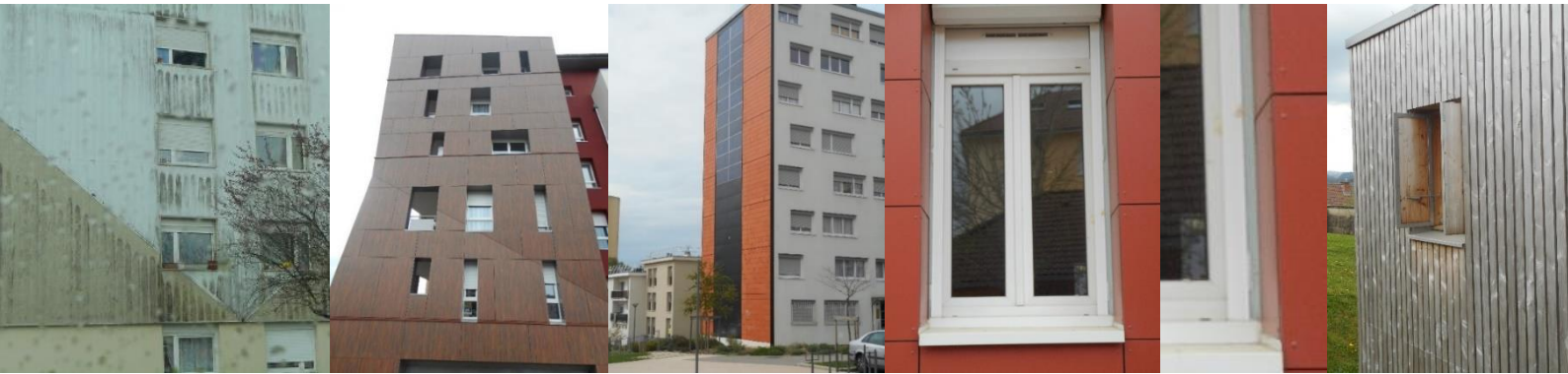
Figure 11 : de gauche à droite, PRE DES SAULES à Bellignat, PLACE DU MARCHE et AV. DES NATIONS à Rillieux-la-Pape, BEAUSEJOUR et MOLIERE à Bellegarde (Source personnelle pour Dynacité)
