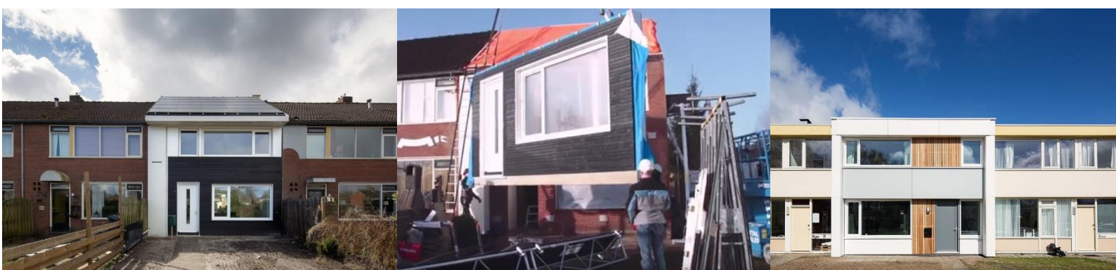
Figure 19 : Réalisation d'EnergieSprong (Sources : sites web energiesprong.eu et lemoniteur.fr)
