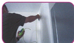
Mesure de la pression derrière une bouche d'extraction à l'aide d'un manomètre
