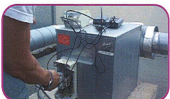
Mesure de l'intensité avec un ampèremètre ou de la puissance électrique avec un wattmètre
