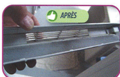
Mousse retirée, passage d'air normal
