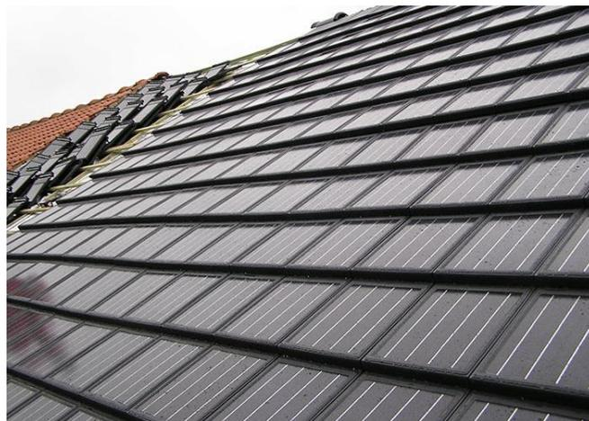
Figure 10 : Photo représentant un toit en cours de couverture avec des tuiles NeoSolPan
