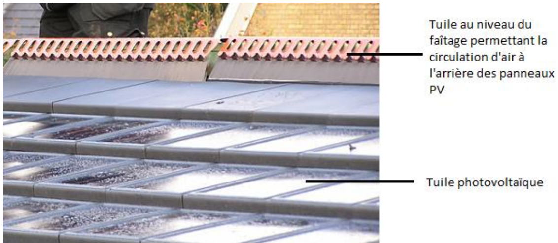
Figure 9 : Photo représentant les tuiles de ventilation en haut du toit
