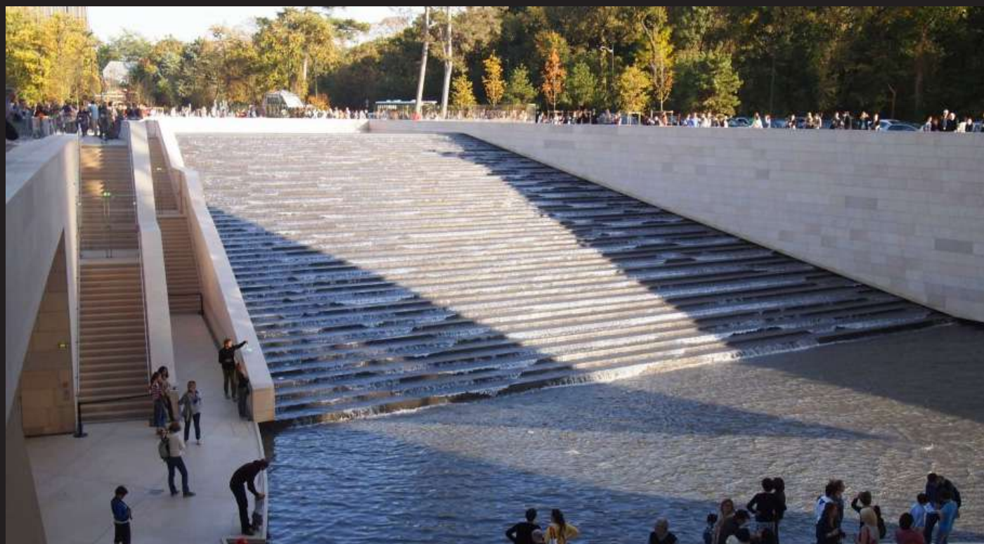
Vue de l'escalier en cascade de la Fondation Louis Vuitton, coté Nord, Octobre 2018
