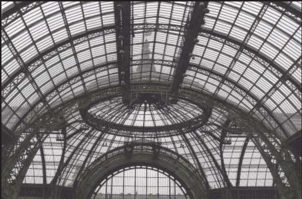
Photo de la Coupole du Grand Palais, les verrières. 14 juillet 2006
