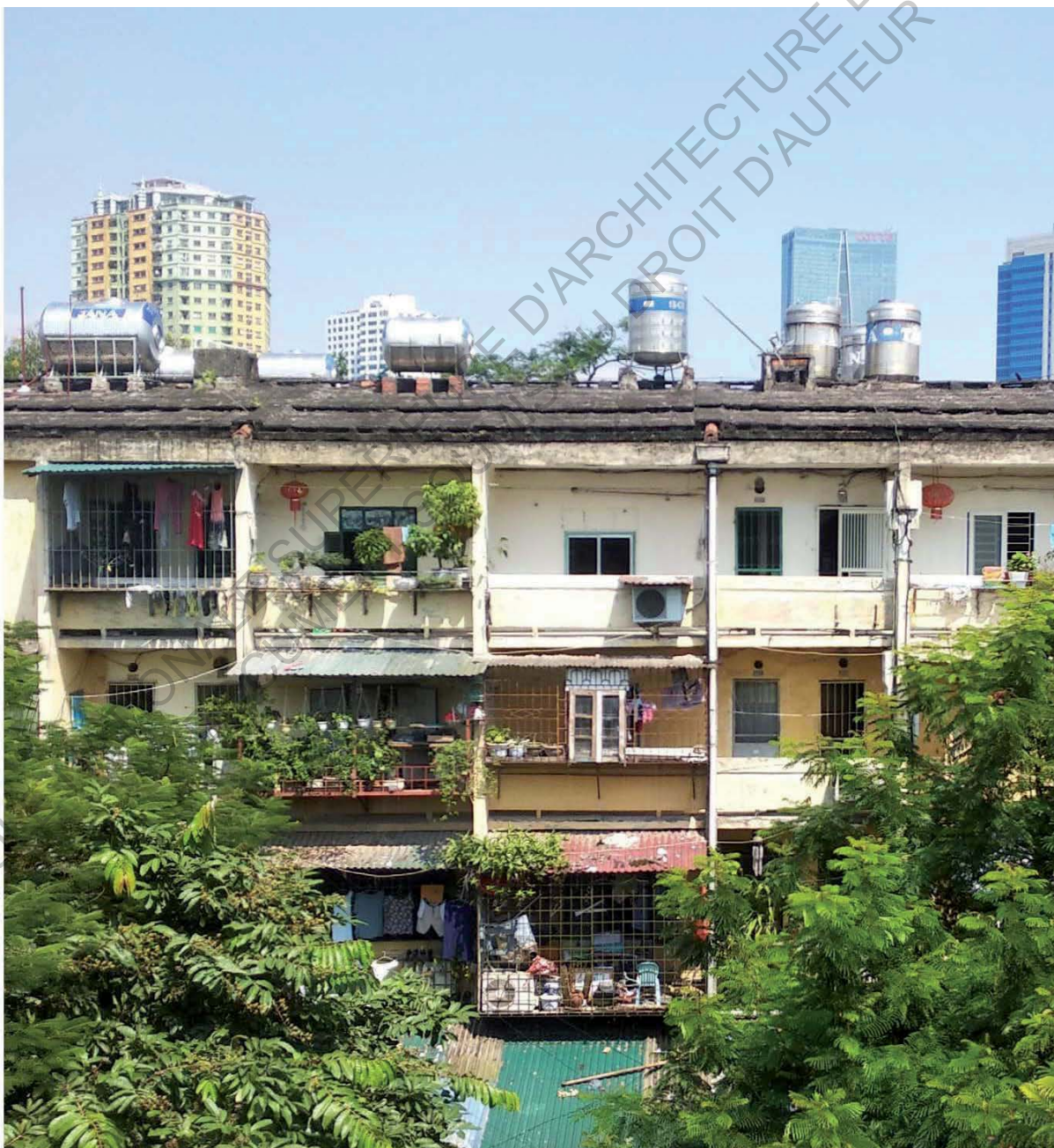
Façade du KTT Thành Công
