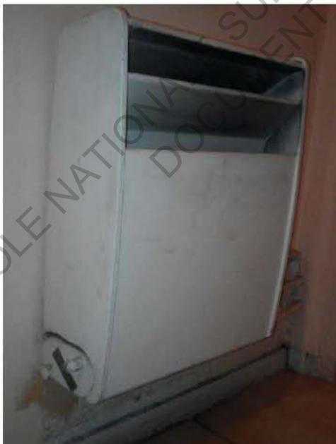
Originellement, les appartements étaient chauffés par des convecteurs alimentés par l'eau chaude produite par les chaudières individuelles. De nombreux propriétaires ont remplacé les convecteurs par des radiateurs en fonte pour des raisons principalement esthétiques mais également de confort. Certains occupants, plus rares, ont installés des convecteurs électriques.
