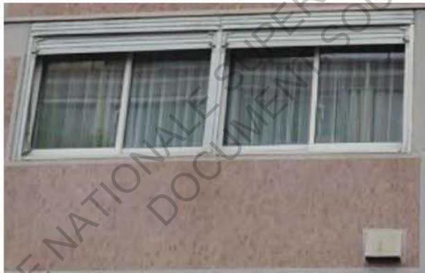
Cette ventilation naturelle est aussi réalisée grâce à une ventilation basse sur façade en cuisine, et une ventilation haute via un conduit Shunt.
