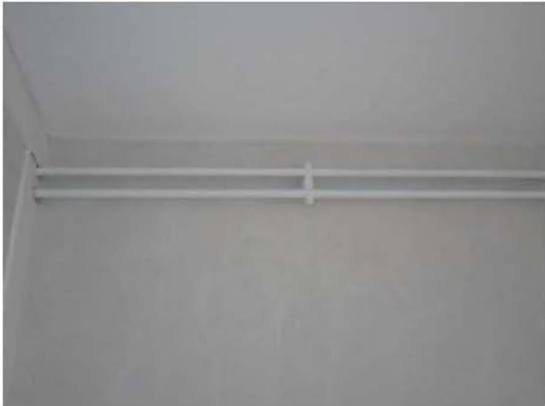
Les gaines d'eau chaude du circuit de chauffage sont visibles dans les appartements. Non calorifugées, elles sont sources d'importantes déperditions.
