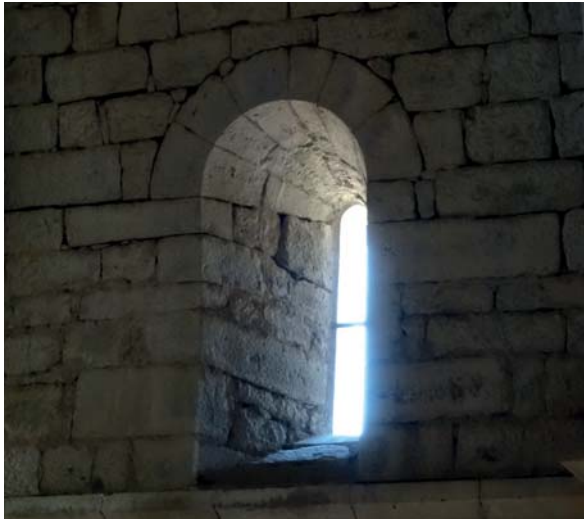
Fenêtre bien appareillée mur Nord, photo F.B.
