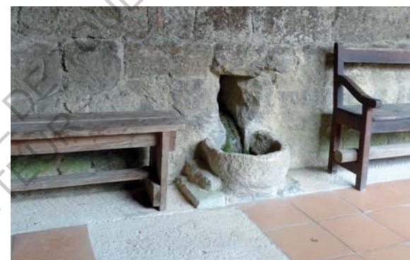
Exutoire existant du cloître, photo F.B.
