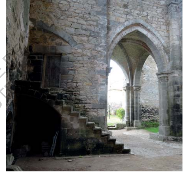
L'escalier du dortoir à Villelongue, photo F.B.
