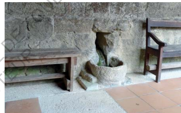
Exutoire existant du cloître, photo F.B.
