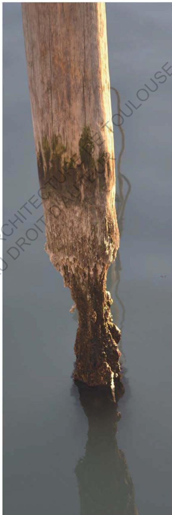
**FIGURE 35 : PIEUX ALTÉRÉ PAR LES REFLUX DE LA MARÉE**
