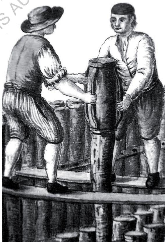
**FIGURE 28 : BÂTISSERS ENFONÇANT DES PIEUX À L'AIDE D'UN MAZZUOLO À L'INTÉRIEUR D'UN CASSERO**
