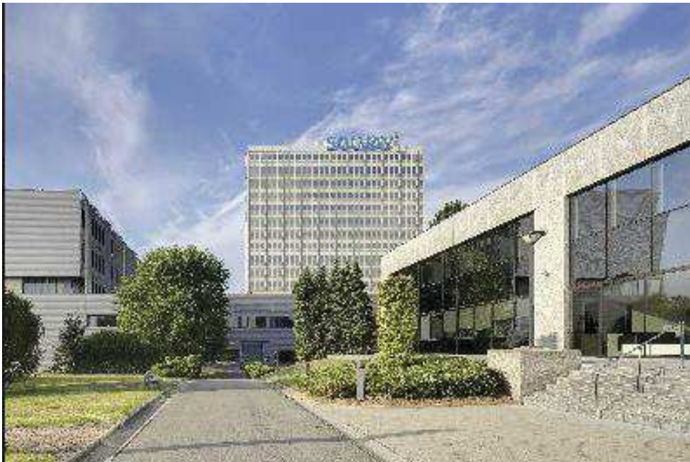
Le campus NOH à Bruxelles, l'entrée sur bâtiment des fonctions dirigeantes
