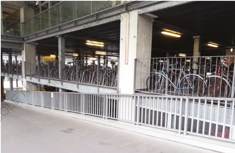
Figure 38 - La rampe menant au parking à vélos. Figure 39 - La rampe menant au parking à vélos.
