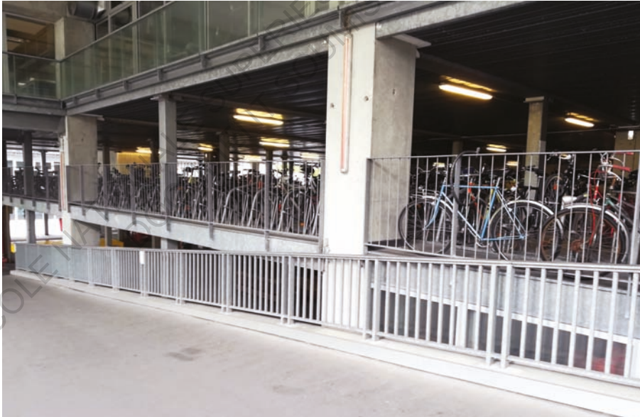
Figure 38 - La rampe menant au parking à vélos.
