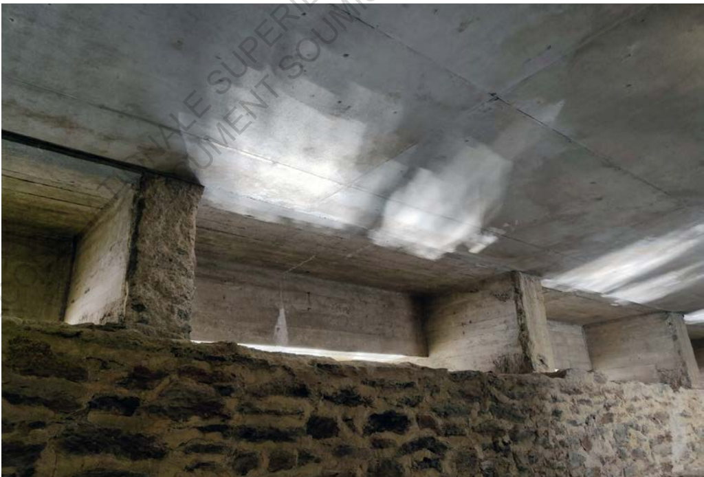
Refler de l'eau sur le plafond en béton dans l'espace méditatif
