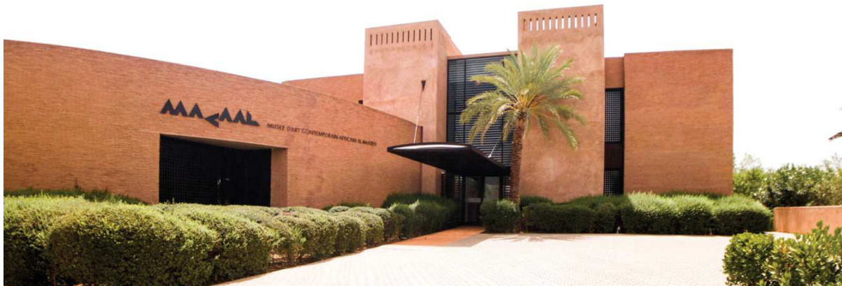
Figure 33. - Photo du bâtiment. Vue de l'entrée principale.
