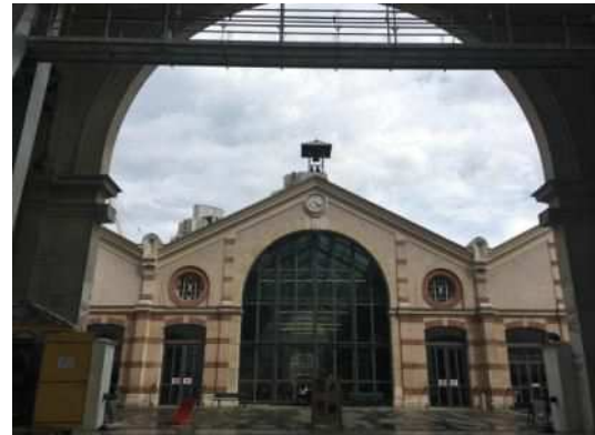
Entrée cour d'Aubervilliers
